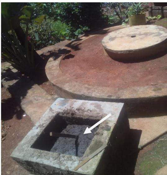
Figure 1: Biodigester de 10M3 installé par FAFAFI/SPAM à Antsirabe avec le récipient destiné à recevoir les fientes de zébus (flèche).
