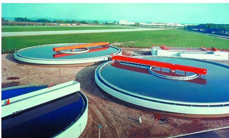
*Photo 1- Décanteur – flocculateur*
