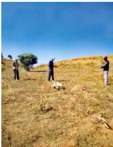
A gauche, mise en place des piquets et à droite, le niveau à eau
