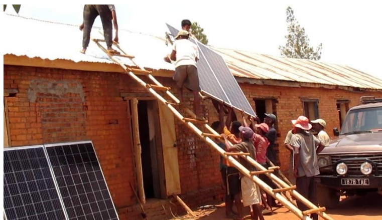
Mise en place des panneaux solaires au CIV
