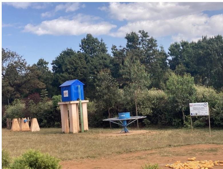
Une pompe à manège
