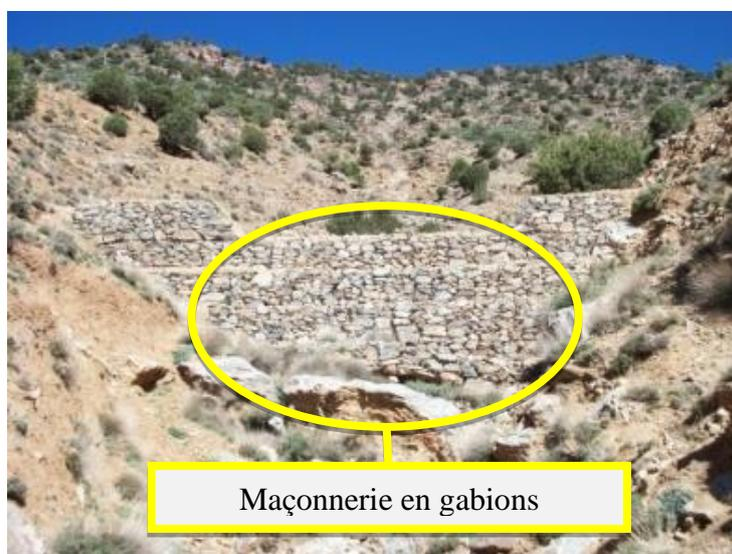
**Figure 42:** Barrage en gabion [W12]
