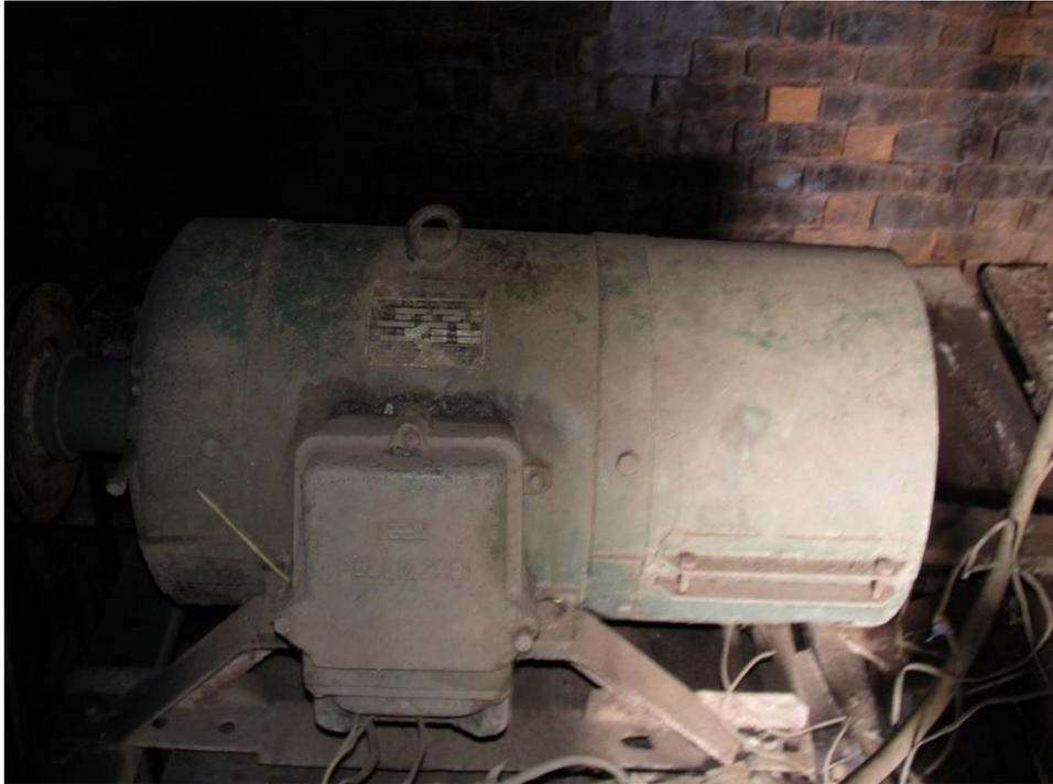
*Figure 24 : Alternateur ELYSTAR PELLIZZARI ; puissance de 30KVA ; facteur de puissance  $\cos \varphi = 0,8$  et une tension d'excitation de 19V courant continue ; en fin une sortie triphasée de tension entre phase de 380 V ; machine synchrone de fréquence de 50Hz*
