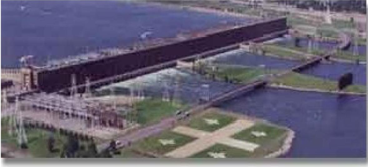
*Figure 3: Centrale de Beauharnois au Québec : Puissance 1660MW ; hauteur de chute 24m*
