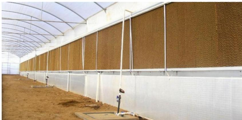
Figure 1.09 : Un système de réfrigération (Cooling) [1.12].
