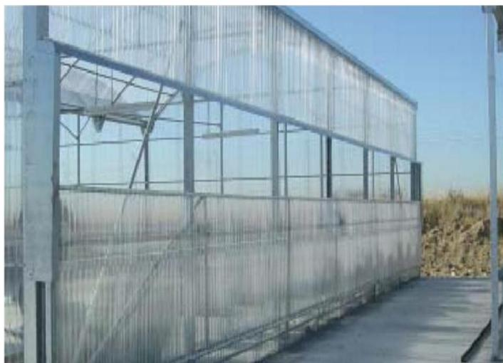
Figure 1.04 : Ouverture par déplacement vertical [1.09].
