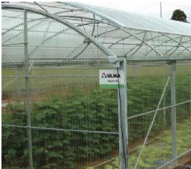
Figure 1.03 : Une aération uniforme située sur le faîtage[1.09].
