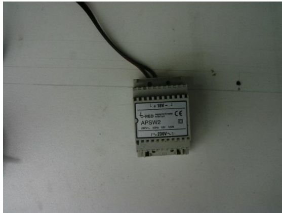
Photo 8: transformateur d'alimentation
