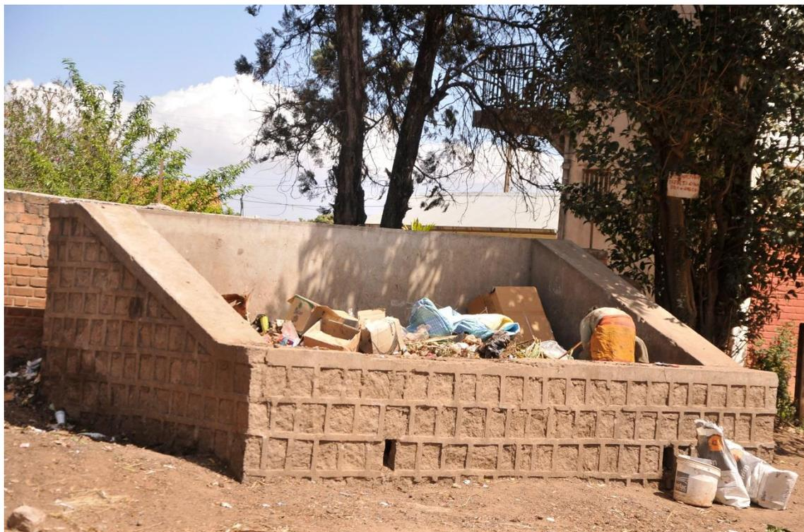
**Photo 10 :** Bac à ordure en maçonnerie
