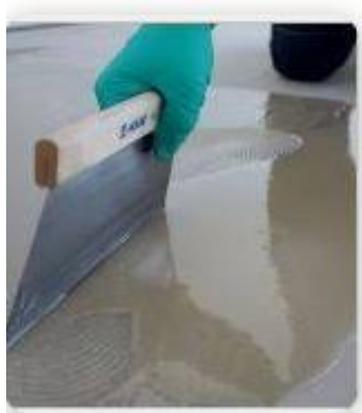
**Figure 12 :** Application de la résine époxy sur le carreau
