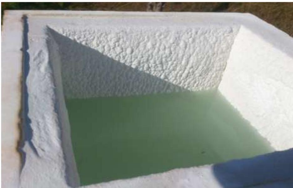
**Photo 3 : bac de traitement d'hypochlorite de sodium**
