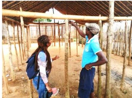
**Photo 28** : Poutre en bambou d'un bâtiment
